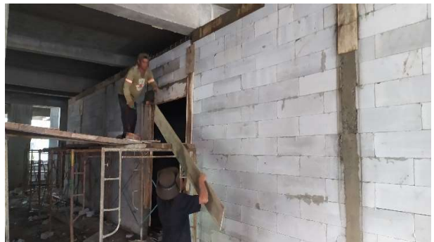
Pemasangan kolom praktis, balok lateu ringbalk & bata ringan Lantai 1
