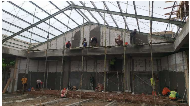
Pekerjaan Plester dinding area Ruang Auditorium
