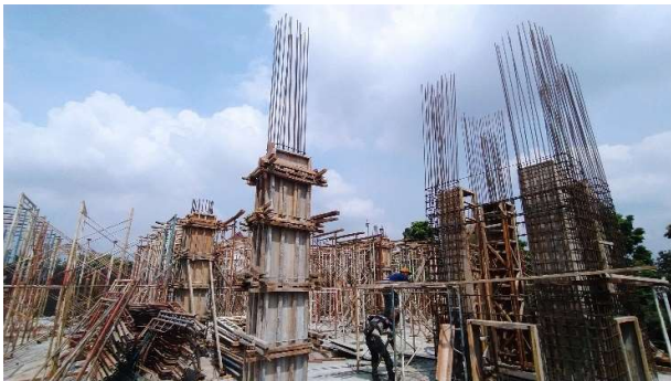
Pembesian & Begisting Kolom Lantai 3
