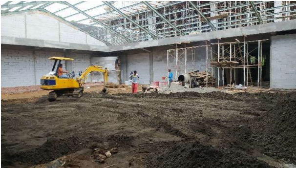
Pengurugan pasir bawah lantai Ruang Auditorium
