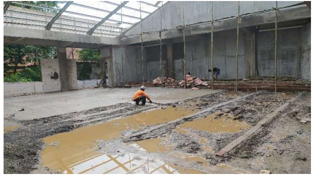
Pemasangan Ruang Auditorium
