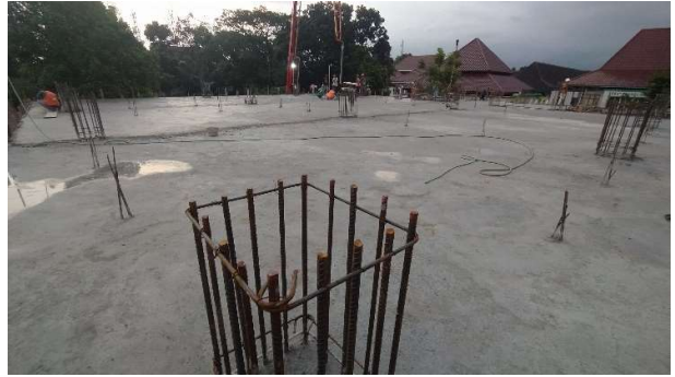
Hasil akhir Pengecoran Plat Lantai 3
