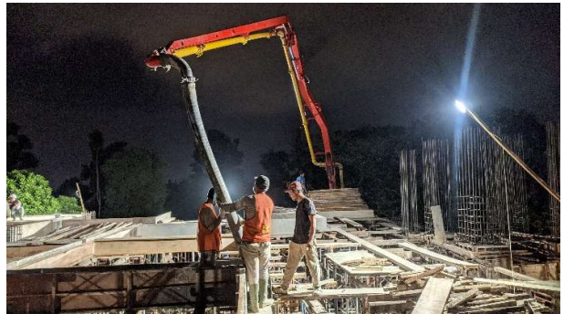
Pengecoran Kolom Lantai 3
