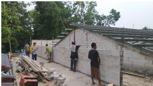
Pemasangan kolom praktis & bata ringan Parapet Lantai 2 Auditorium
