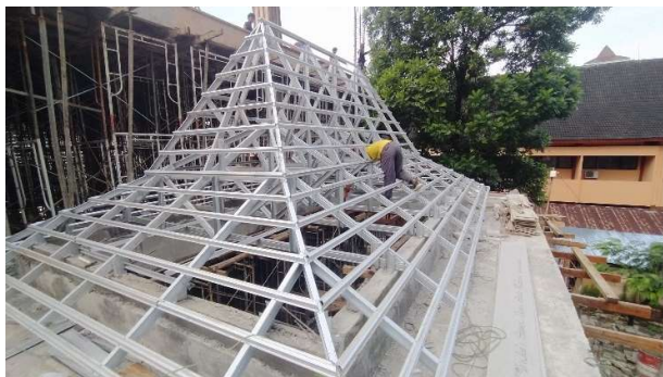
Pemasangan Rangka atap baja ringan
