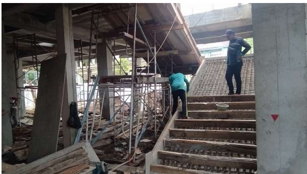
Pembesian dan Begisting Tangga Lantai 1
