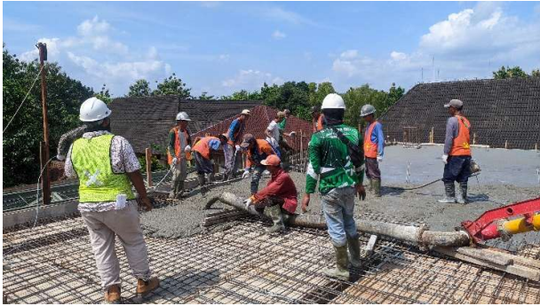
Pengecoran Plat Lantai 3
