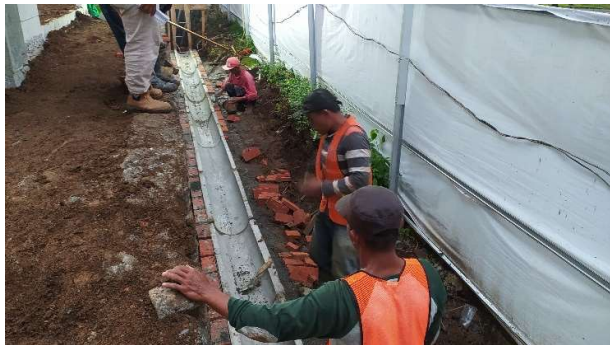
Pekerjaan saluran buis ½ Timur Bangunan
