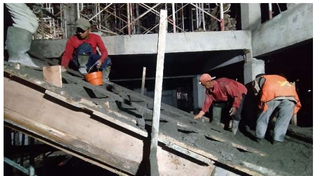
Pengecoran Tangga Lantai 1
