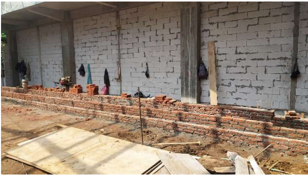
Rollag bata trap Panggun Ruang auditorium
